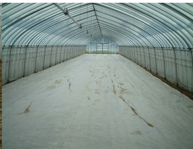
ビニールによる被覆
