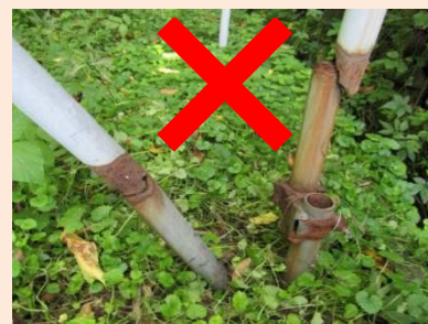
■劣化したパイプは交換
