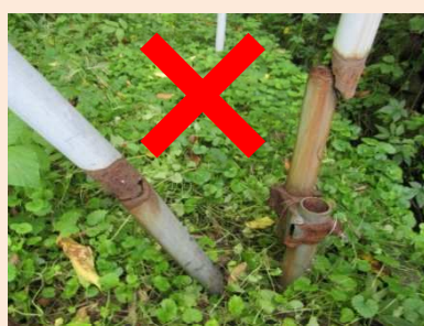
■ 劣化したパイプは交換
